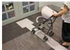
屋内用視覚障がい者誘導システム 「UDフロアシステム」 田島ルーフィング㈱/樹クワハウスデザインオフィス/ 近畿大学理工学部社会環境工学科福祉環境計画学研究室 ベビーカーや車いすの移動を 妨げない点字ブロック
