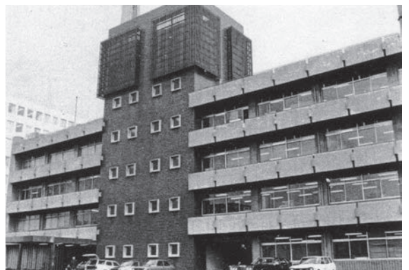
浜松町に移転した東京都計量検定所
