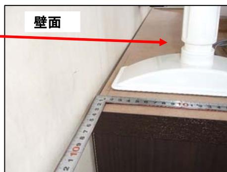
写真6 ポール式器具の設置部分
