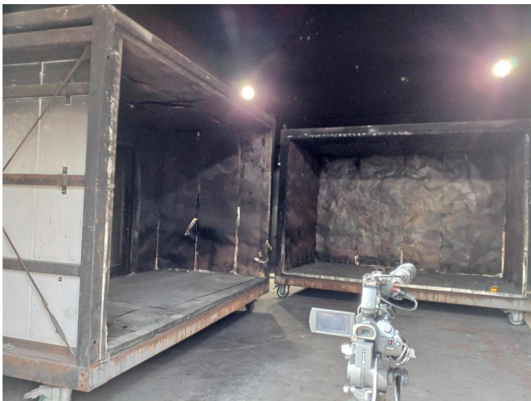
図 47 燃焼実験棟内の状況
