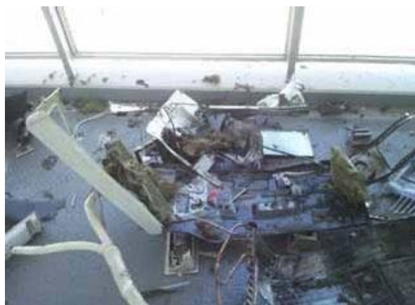
図1-1 破裂したエアコン室外機
